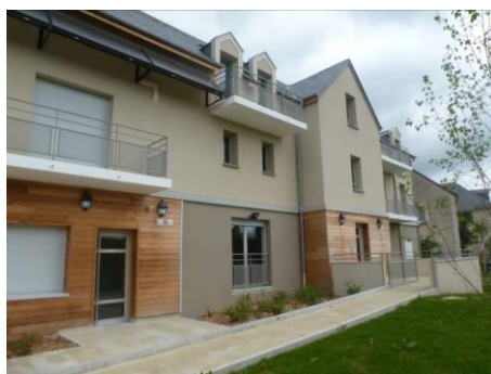
Résidence sociale FJT de 7 logements à Langeais (Indre-et-Loire)
